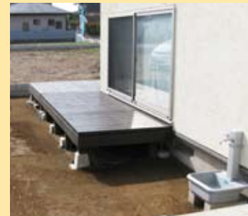
東面仮設デッキ
