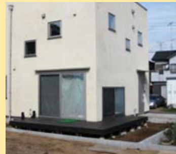
建物南側全景
